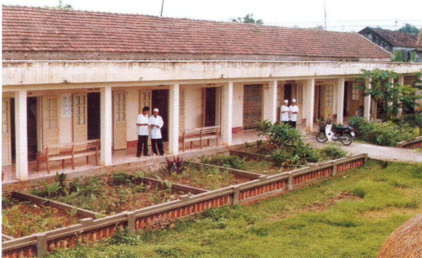
Trạm xá xã Văn Xá được xây dựng năm 1982.
