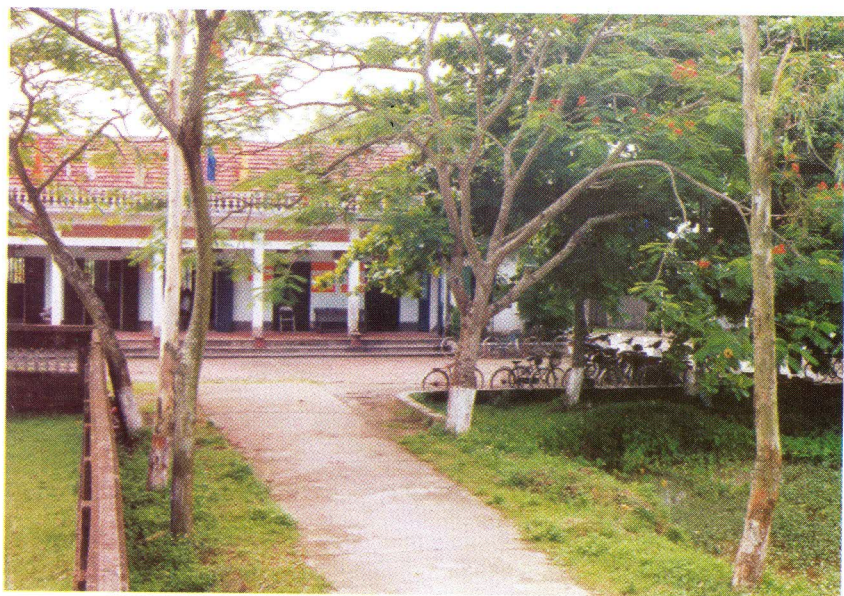
Trụ sở UBND xã được xây dựng năm 1987.
